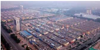
聊城市东昌府区香江光 彩大市场6517家商户 智慧消防建设项目
