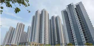
合肥市平板显示基地公 租房4856户公寓消防 社会化服务项目
