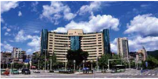
达州市达川城区114家 商铺智慧消防社会化服 务项目
