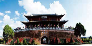
大理州巍山县南诏古城 173家九小场所智慧消 防建设项目
