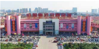
临沂市兰山商城40000 商户智慧消防系统项目
